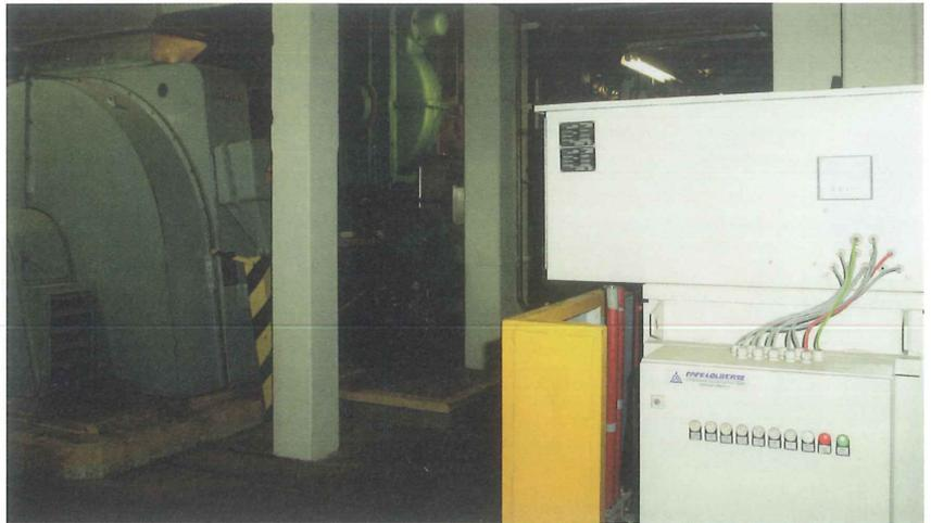
**Bild 3.** Das Besondere an der Starterlösung ist, dass der Schleifringläufermotor des Holzschleifers über die Schütze Sirius 3RT im Asynchronbetrieb als Ponymotor gestartet und anschließend auf Synchronbetrieb umgeschaltet werden kann; dadurch erhöhen sich Leistung und Wirkungsgrad im Dauerbetrieb
