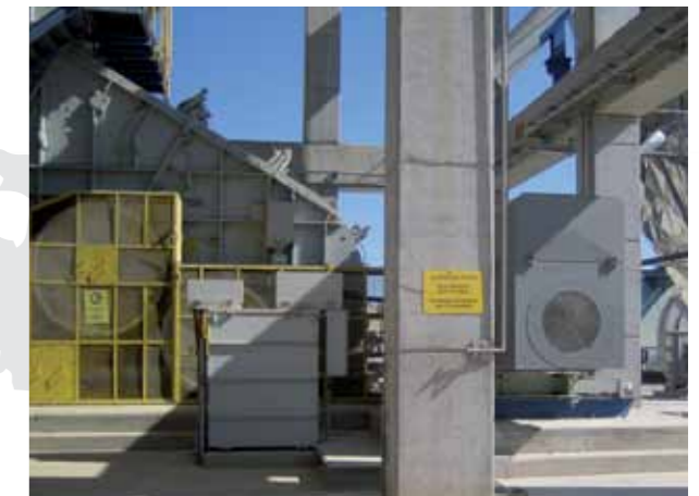
Ölanlasser für Zementmühle Liquid starters for cement mill
