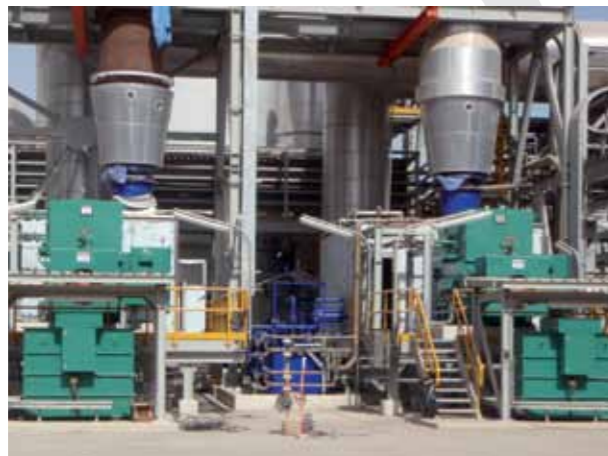
Flüssigkeitsanlasser für Kompressor Liquid starters for compressor
