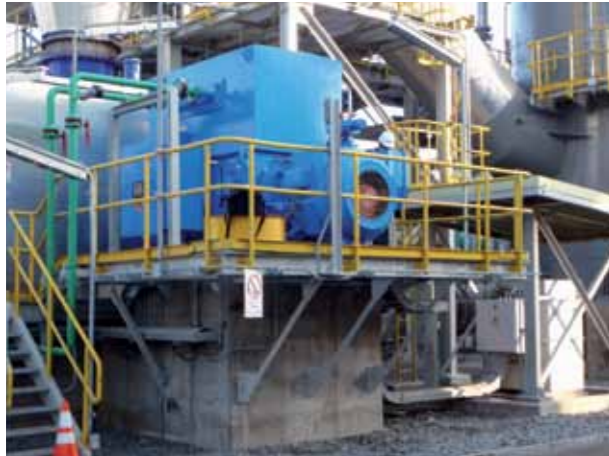
Flüssigkeitsanlasser für Gebläse Liquid starters for fan
